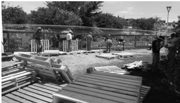
Figura 6: Proceso de construcción de PAZ Fuente: Tráfico (ZMG, 2016) 31 .
